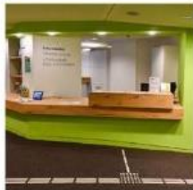
Kontrastreiche Leitstreifen, Beleuchtung und Beschriftung führen zur Information mit zwei Tresenhöhen.
