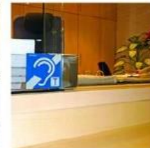
Deutliche Kennzeichnung, dass der Empfangsbereich mit einer Induktionsschleife ausgestattet ist.
